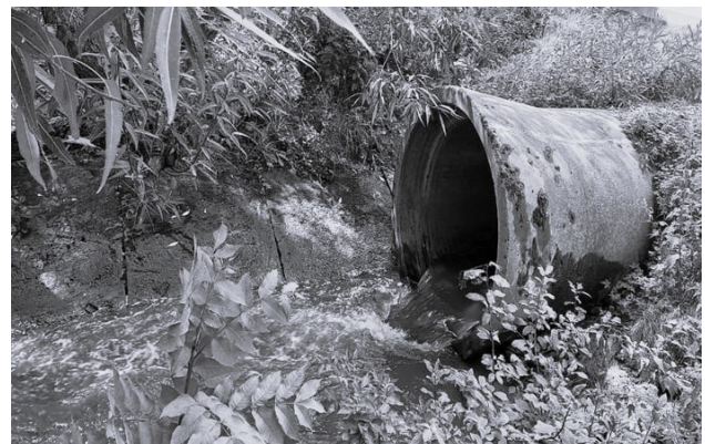
Рис. 1. Каналізована ділянка русла річки Зубра в яку скидаються неочищені каналізовані стоки з житлового масиву Сихів. Фото авторів
